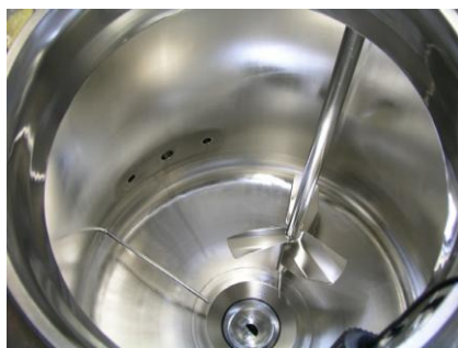
Edelstahlbehälter Werkstoff 1.4435 vor und nach Oberflächenbehandlung vor Ort mit optimierten Henkel-Verfahren
