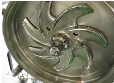
Pumpenlaufrad mit Rougebelag und nach Derougingbehandlung mit HENKEL Bioderouging-Lösung HC 4200
